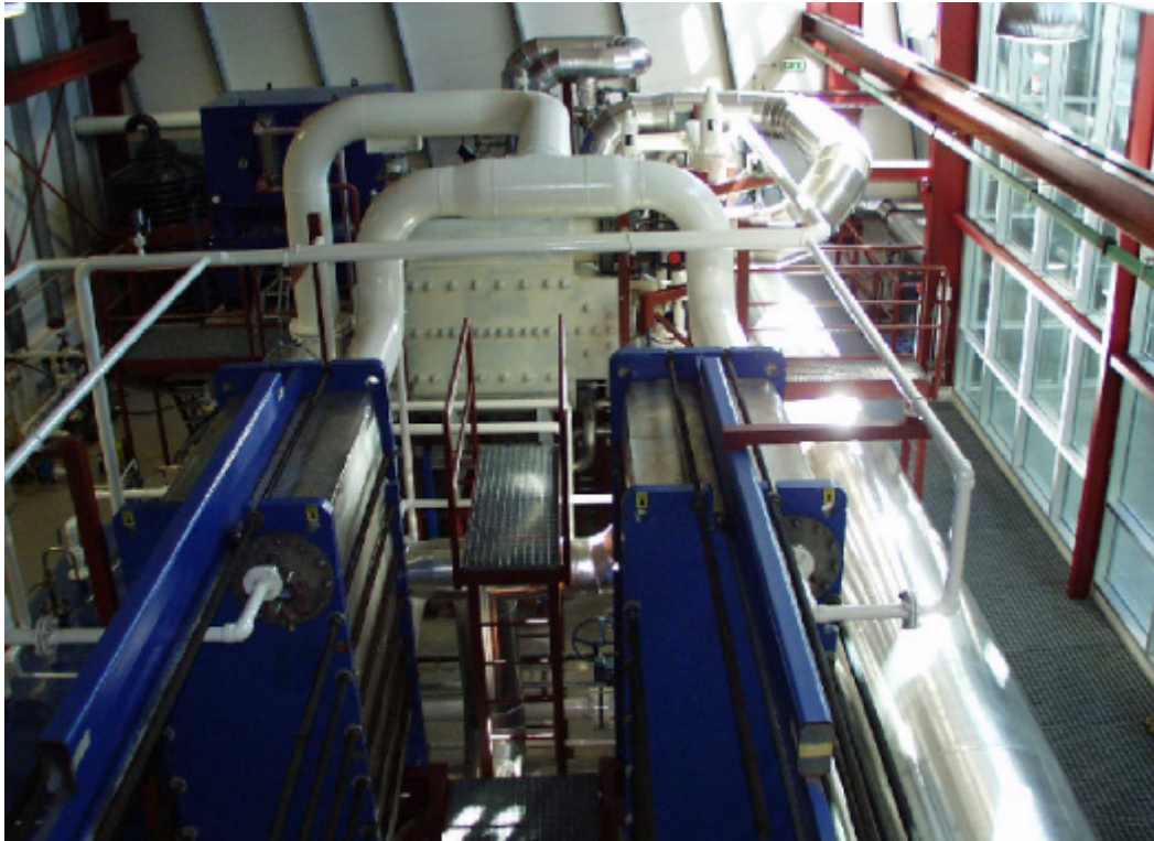
Mynd 4.4.1.1. Úr sal: eimsvalar í forgrunni, hverfil-rafalásamstæða í bakgrunni
