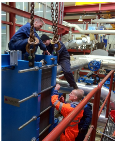
Unnið við varmaskipti
