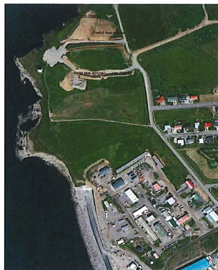
Mynd 2 – Áætluð sprunga yfir Húsavíkurhöfða
